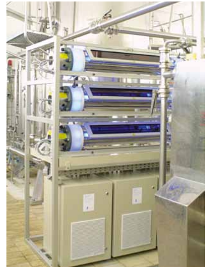
Dieser UV-Reaktor wurde speziell für die Anwendung in der Pharmaindustrie entwickelt.
