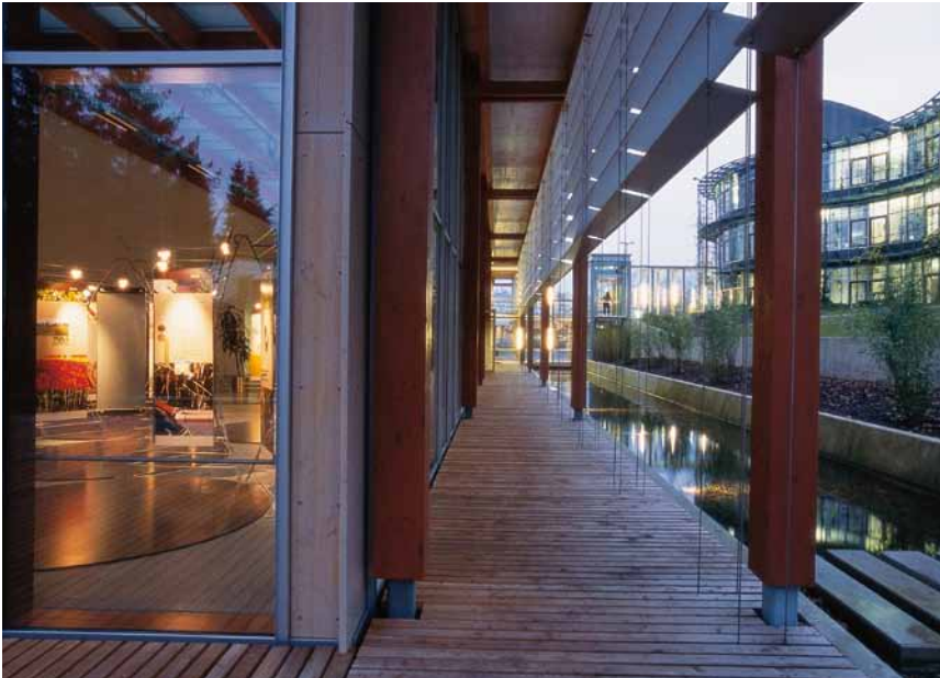
Der Neubau des Zentrums für Umweltkommunikation (ZUK) wurde nach neuesten bauökologischen Gesichtspunkten errichtet.
