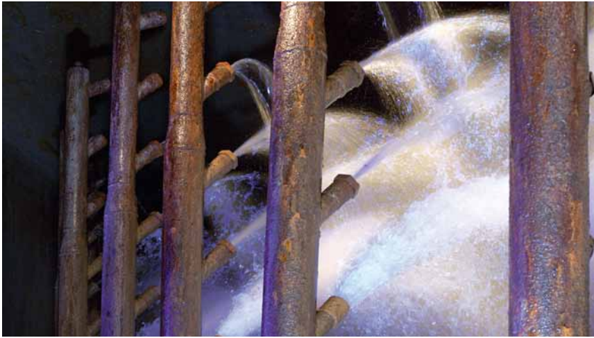
Hier wird Rohwasser über Düsen versprüht, um es mit Sauerstoff anzureichern.
